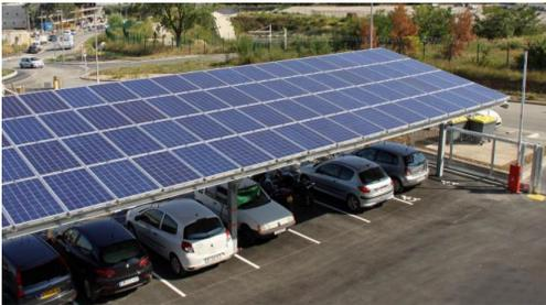
Exemples d'implantation de panneaux solaires sur les toitures d'ombrières
